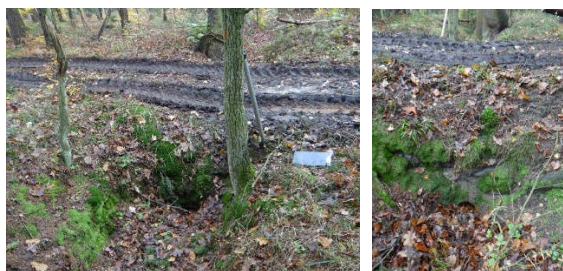
FOT. 53 OBIEKT NR 732.7.4 – ISTNIEJĄCY PRZEPUST W LEŚNICTWIE BOREK, ODDZIAŁ 148A; A) WLOT PRZEPUSTU, B) WYLOT PRZEPUSTU
