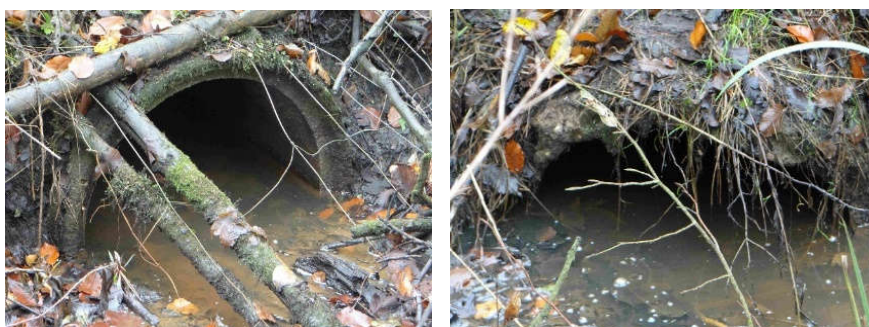
FOT. 9 OBIEKT NR 732.7.25 – ISTNIEJĄCY PRZEPUST W LEŚNICTWIE BOREK, ODDZIAŁ 193K; A) WŁOT PRZEPUSTU, B) WYŁOT PRZEPUSTU
