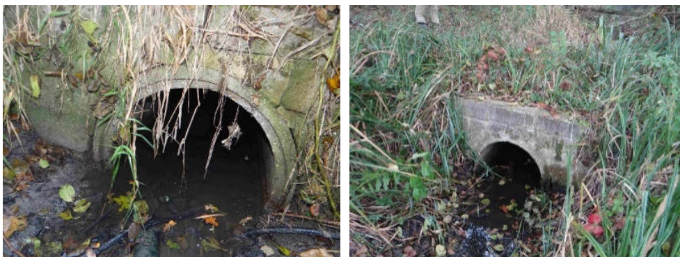
FOT. 21 OBIEKT NR 732.11.38 – ISTNIEJĄCY PRZEPUST W LEŚNICTWIE CHODLEWO, ODDZIAŁ 346S; A) WLOT PRZEPUSTU, B) WYLOT PRZEPUSTU
