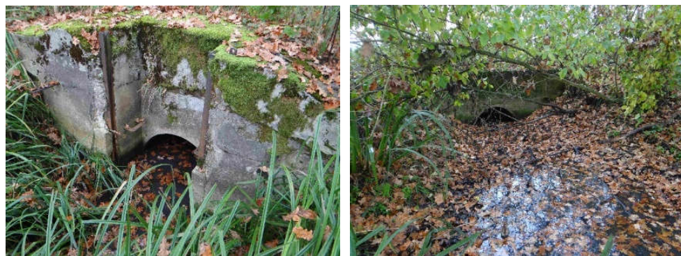
FOT. 22 OBIEKT NR 732.11.39 – ISTNIEJĄCY PRZEPUST Z ZASTAWKĄ W LEŚNICTWIE CHODLEWO, ODDZIAŁ 346J; A) WYLOT PRZEPUSTU, B) WLOT PRZEPUSTU
