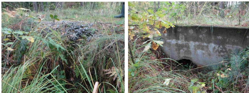
FOT. 3 OBIEKT NR 732.3.25 – ISTNIEJĄCY PRZEPUST W LEŚNICTWIE KONIOWO, ODDZIAŁ 108c; A) WLOT PRZEPUSTU, B) WYLOT PRZEPUSTU
